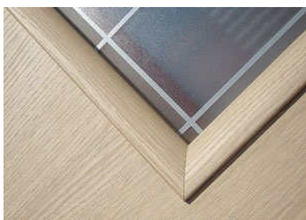
Итальянский широкий багет. Стыки багета соединя клеевым швом.
